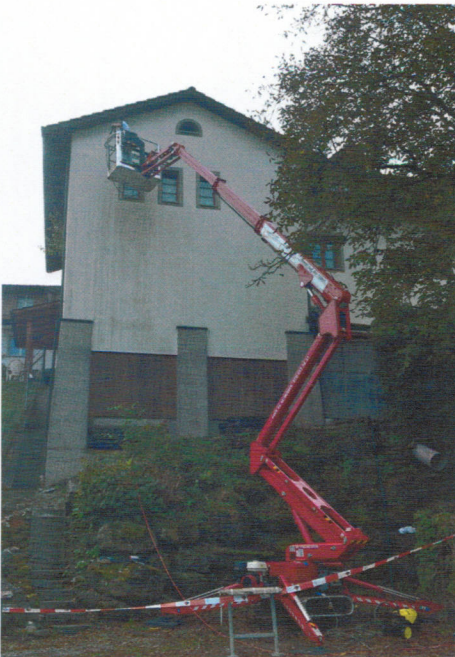
Teleskopbühne: Einsatz im Gelände
