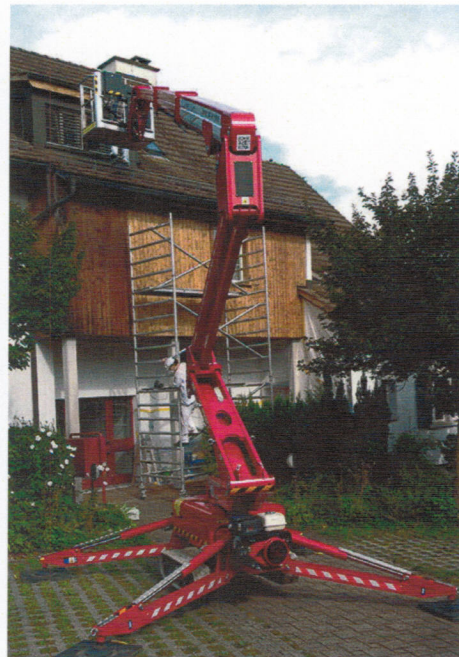
Gemeinsamer Einsatz: Teleskopbühne und Rollgerüst
